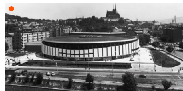
Administrativní budova Ingstav Brno, Videňská 546/55, Brno Ivan Ruller, 1968–1970
