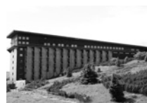
Labská bouda Bedřichov 31, Špindlerův Mlýn Zdeněk Řihák 1969–1975
