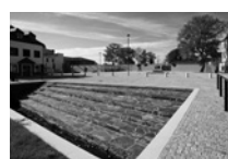
Rekonstrukce Zámeckého náměstí a parku Zámecké náměstí, Velká Bystřice Michal Sborwitz architekti 2009–2010
