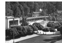
Velká a malá kolonáda, hala Vincentky a Vyšetřovací ústav / Lázeňské náměstí, Luhačovice / Oskar Poříška / 1940, 1942–1944, 1947–1951
