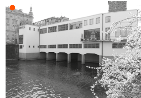
Štencův dům, Salvátorská 931/8 a 1092/10, Praha Otakar Novotný, 1909–1910
