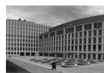
Budova CPTO Univerzity J. E. Purkyně Pasteurova 3544/1, Ústí nad Labem Petr Pelčák 2015–2020
