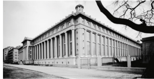
Podolská vodárna, Podolská 15/17, Praha Antonín Engel, 1923–1928, 1956–1957
