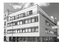
Městská spořitelna Karlovo náměstí 106/57, Třebíč Bohuslav Fuchs 1931
