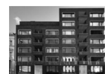
Polyfunkční dům Bratislavská Bratislavská 22–24, Brno Tomáš Rusín, Ivan Wahla, Libor Šupler 2017
