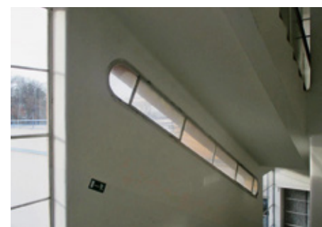
Pavilon nemocnice Bulovka, pavilon 9 (kožní), Praha Jan Rosůlek, 1935–1936
