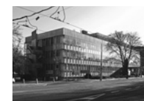
Administrativní budova Ingstav v Brně Videňská 546/55, Brno Ivan Ruller 1968–70
